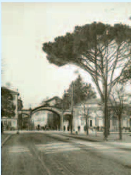
Arco di Porta Cussignacco demolito nel 1920
