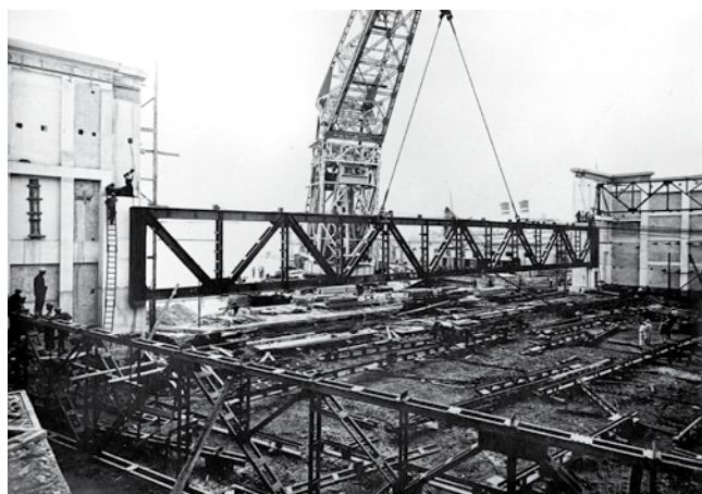
Idroscalo di Trieste. Fase di montaggio della grande trave del portale (foto: Consorzio Culturale Monfalconese)
