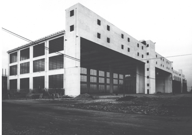
Gli edifici per il montaggio degli idrovolanti (foto: Consorzio Culturale Monfalconese)
