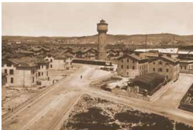
Il Quartiere di Panzano. Le case operaie ed il serbatoio dell'acqua (foto: Consorzio Culturale Monfalconese)
